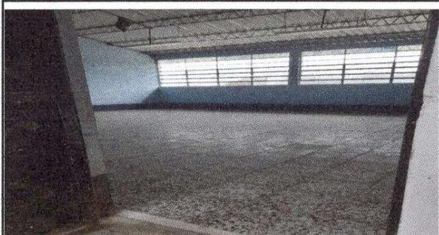
Foto 3: piso de granito instalado
