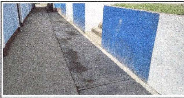
Foto 5: Piso de torta de concreto de 5cm de grosor instalado
